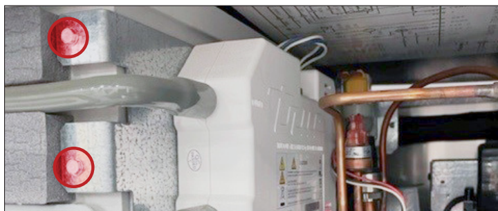
Рис. 3. УФ-система TrueZone, вид сбоку. Места установки винтов для крепления кронштейна системы TrueZone.
