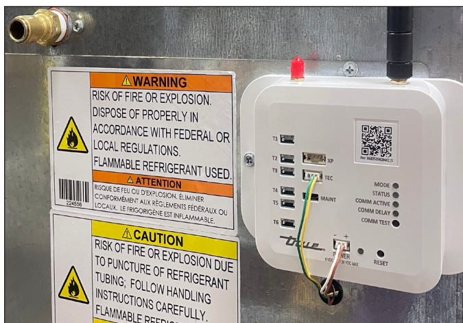
Rys. 2. Wiązka modemów podłączona do modemów. Zielony/żółty do TEC; brązowy/biały do ZASILANIA.
