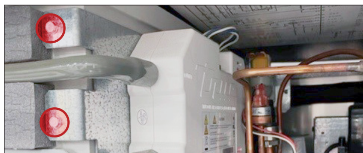
Afb. 3. Zij-aanzicht TrueZone uv-systeem. Locaties van schroeven voor TrueZone-houder.
