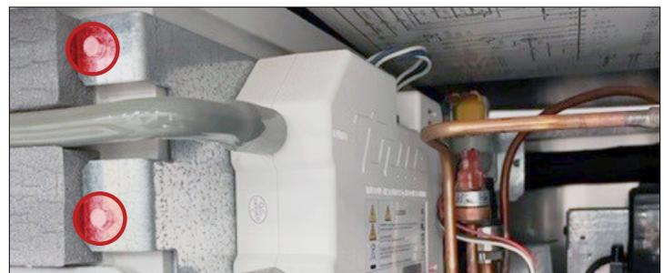
Figure 3. Vue latérale du système UV TrueZone . Emplacements des vis du support TrueZone .
