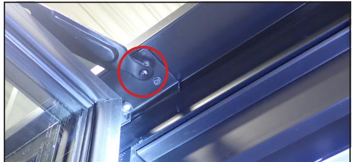
**Fig. 15.** Emplacement de la vis du support de maintien en position ouverte sur le haut de la porte.
