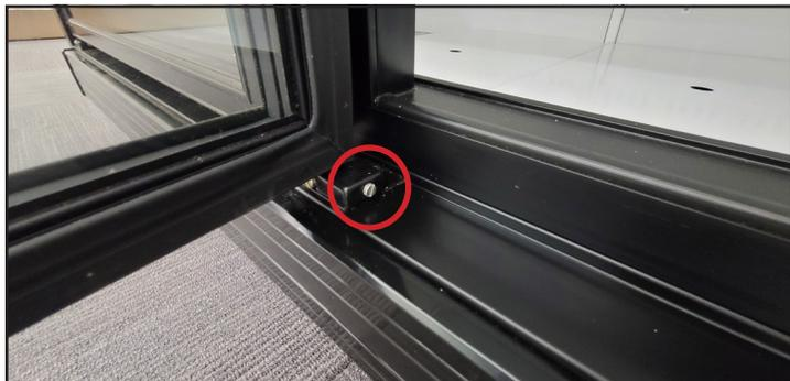
Fig. 3. Ubicación del tornillo de ajuste de alineación de la puerta en la parte inferior de la puerta.
