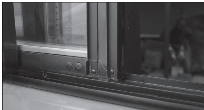
Fig. 2: Trava da porta na posição fechada (solta do encaixe).
