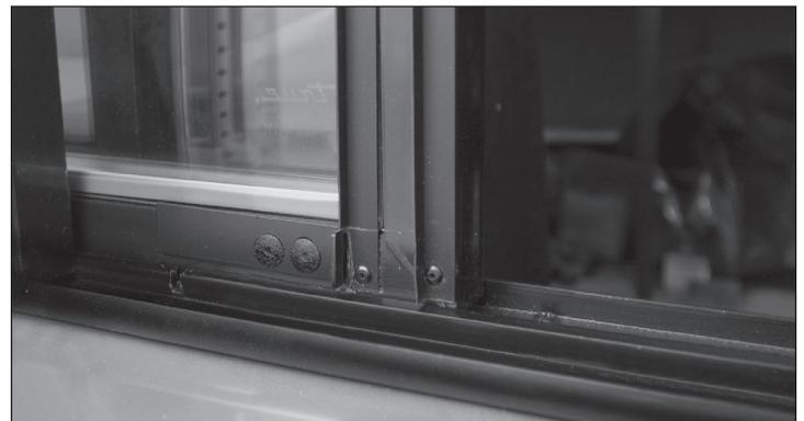
Fig. 2 Il chiavistello dello sportello è in posizione chiusa (non inserito nell'incavo).
