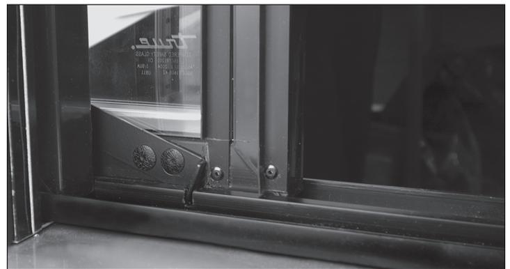
Fig. 1 Il chiavistello dello sportello è in posizione aperta (inserito nell'incavo).
