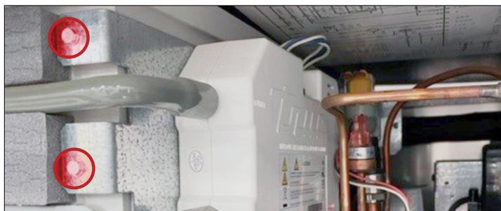
Fig. 3. Vista lateral del sistema de luz ultravioleta de TrueZone. Ubicaciones de los tornillos del soporte de TrueZone.
