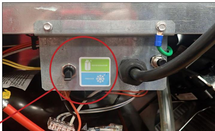
**Figure 1.** Emplacement de l'interrupteur TRUE FlexTemp.
