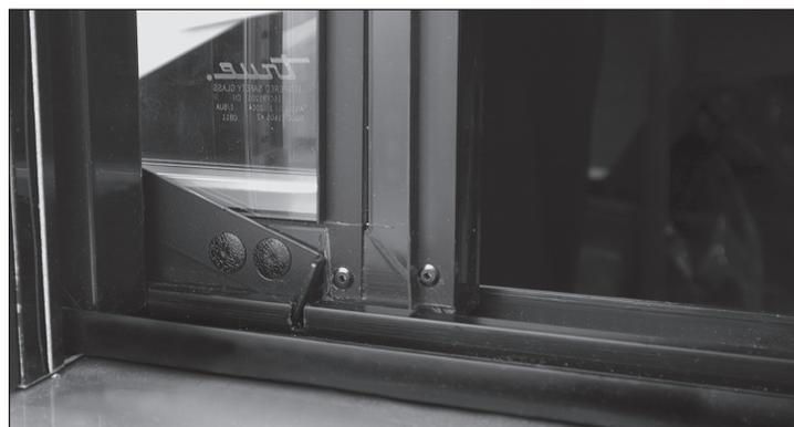
Fig. 1. Il chiavistello dello sportello è in posizione aperta (inserito nell'incavo).
